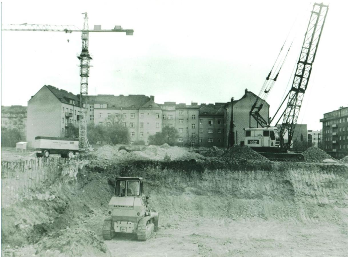
Hier sind die ersten Baumaschinen aufgefahren. Das Gebäude wird auf runden Pfeilern fundamntiert, die mit Rammen in den Boden geschlagen und mit Beton ausgegossen werden.
