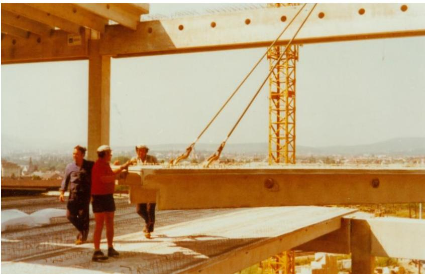
**Einige Fotos vom Rohbau. Die Fertigbetonteile, sowohl Steher als auch die Träger und Platten sind teilweise schon aufgelegt. Frühjahr 1976**
