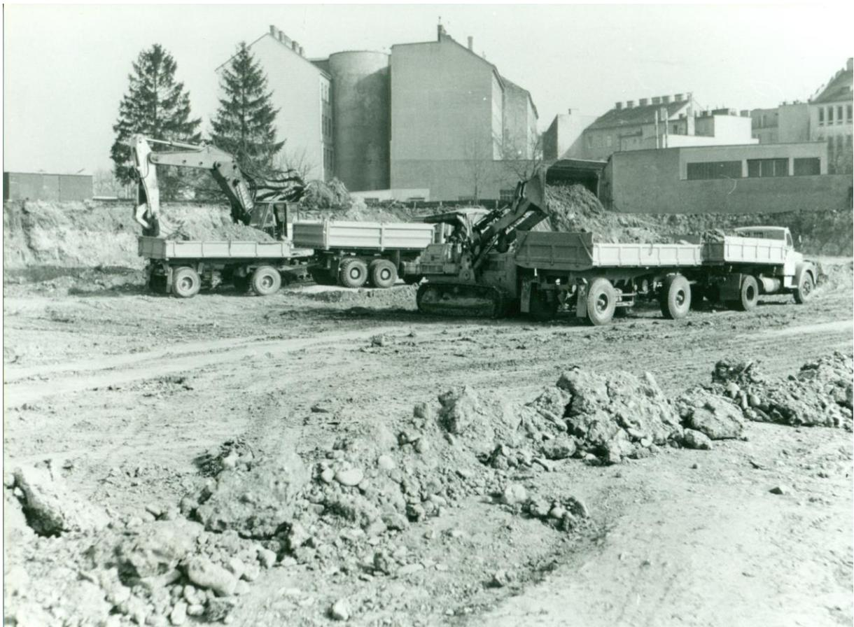
Nachdem ein Schornstein und alte Fabrikgebäude demoliert waren, begann der Bau mit den Erd- Aushubarbeiten und Fundamentierung.
