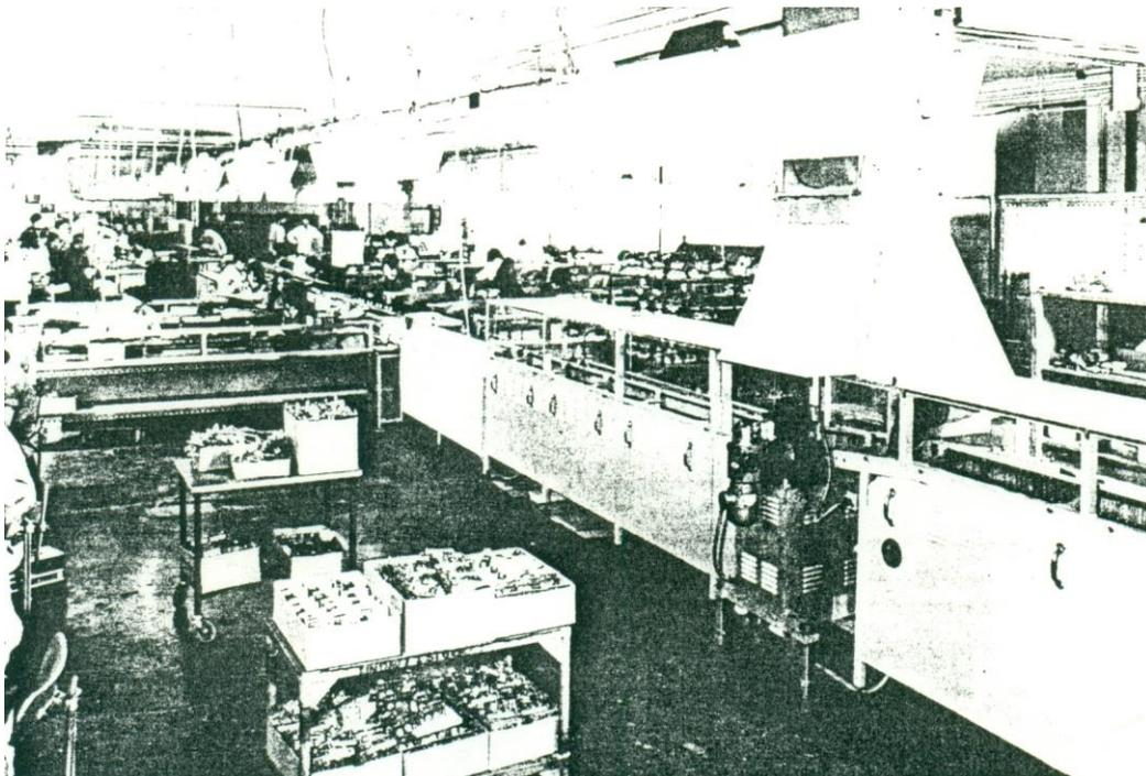
In der "BAUSTEINFERTIGUNG" werden die Bauteile in als Drehteller ausgeführten Behältern, sortiert angeboten. Die Arbeitskräfte stecken gemäß vorliegenden Bestückungsmuster nun die Bauteile in die Druckplatte.
